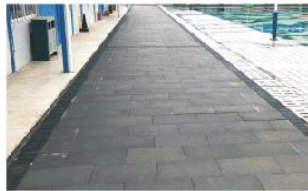
中建一局长浜路工地项目
